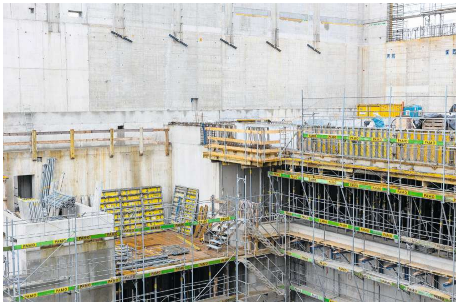
Hochbau am Beispiel des Erneuerungsbaus der Kebag in Zuchwil.
