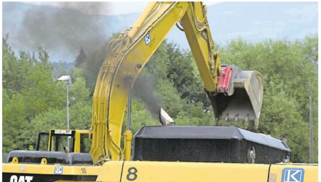
Mehr als 90 Prozent der Baumaschine erfüllen heute die Umweltnormen.
